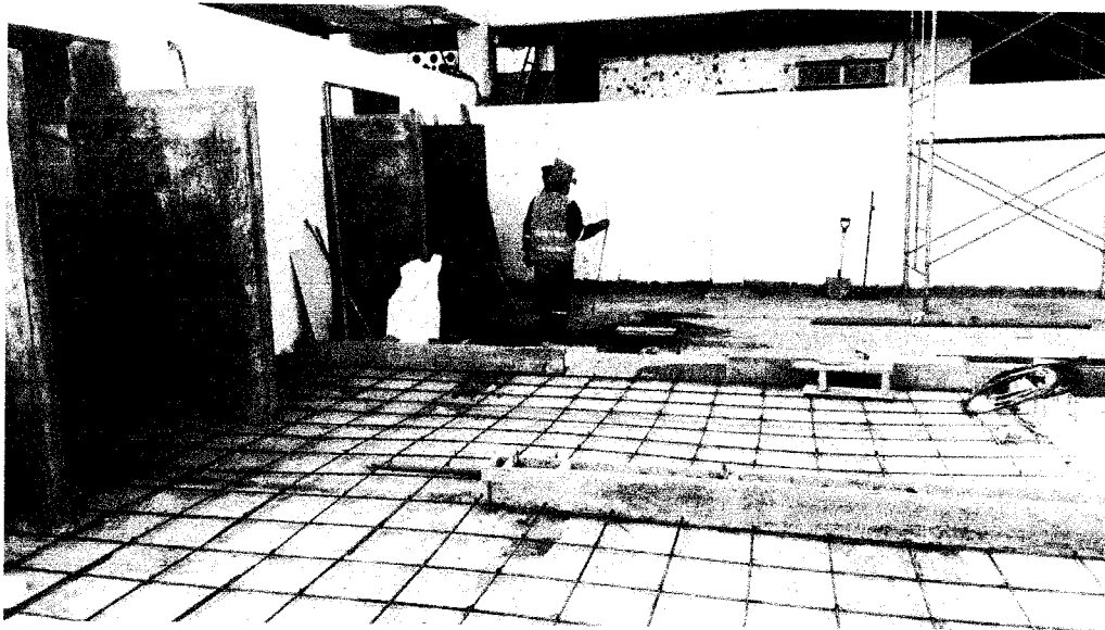
Fotografía 10.- Construcción de muro con bloque de concreto.
