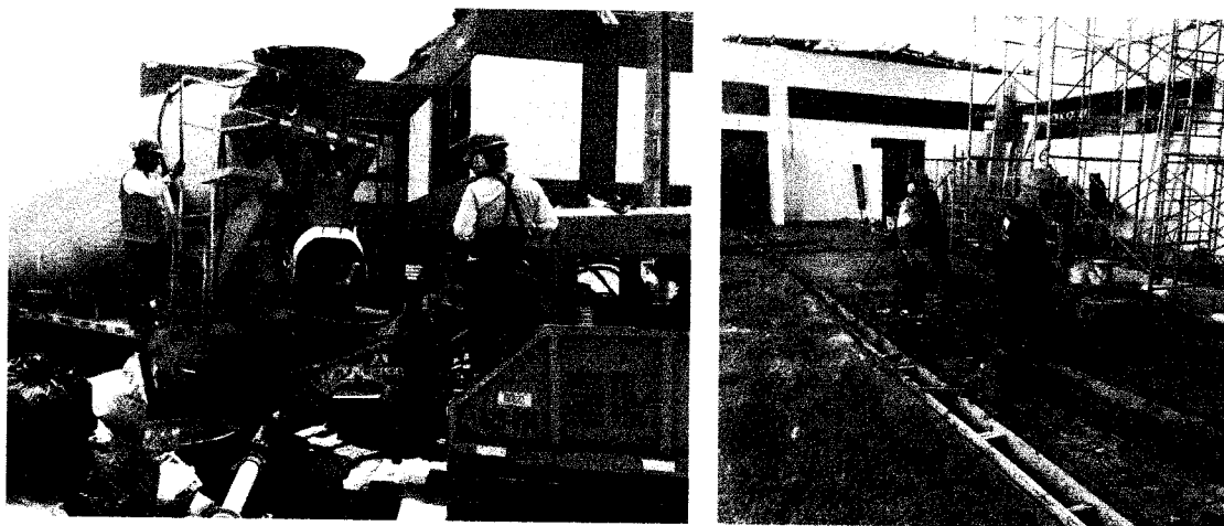
Fotografía 6.- Vaciado de concreto en piso f'c=280 Kg/cm 2 con cemento Tipo V.
