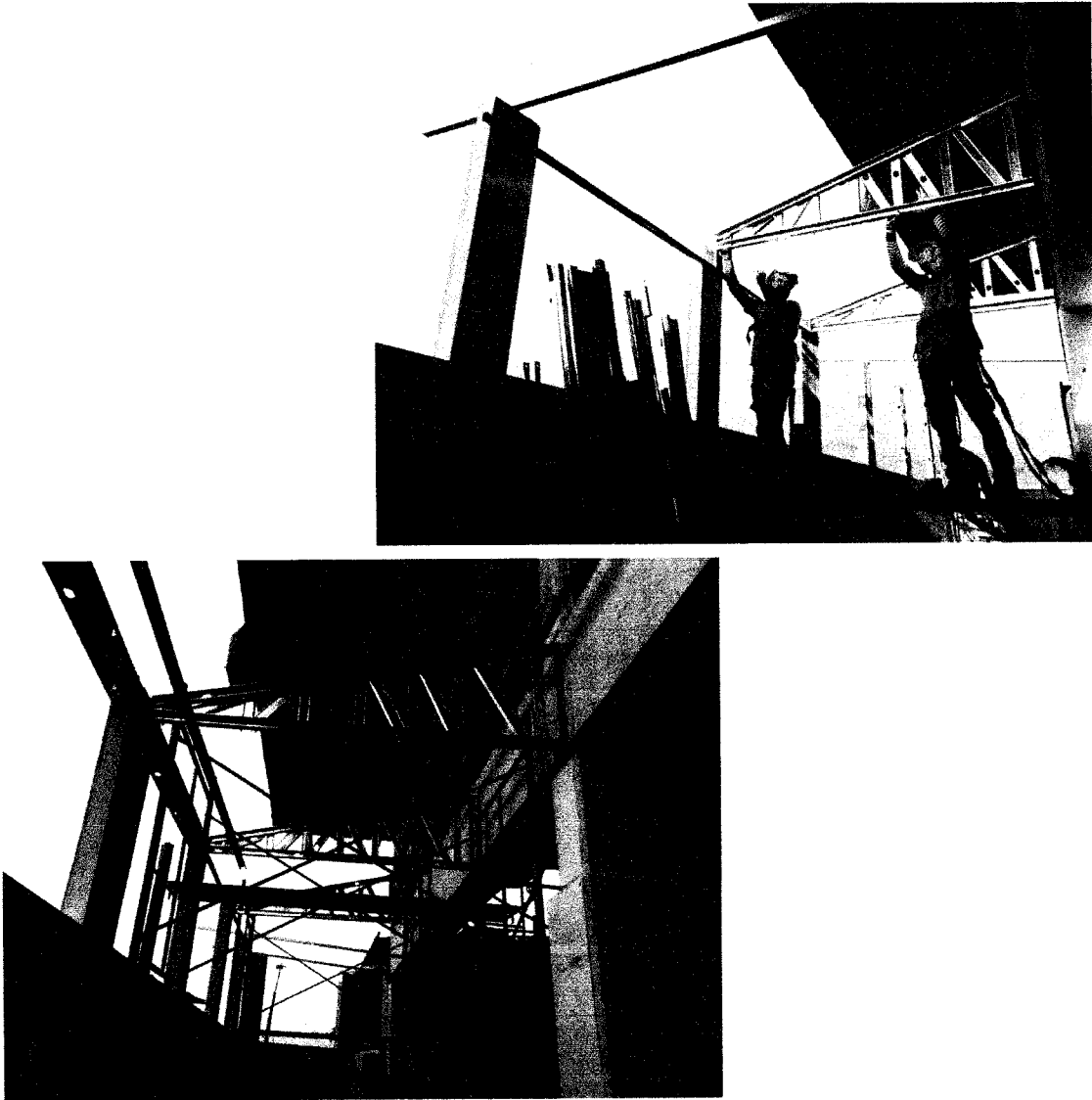
Fotografía 8.- Instalación de Viguetas de Drywall 3 5/8" x 0.45MM.
